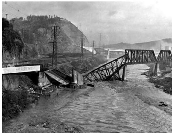
Un puente de ferrocarril destruido por las inundaciones del río, 4 de marzo, 1941.
